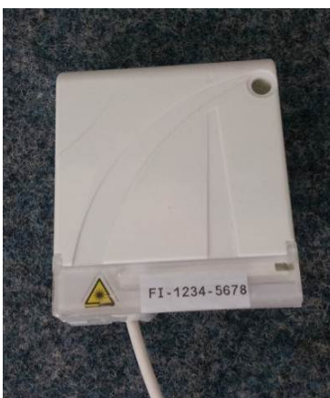
Figure 2 : repérage sur la prise mono fibre
